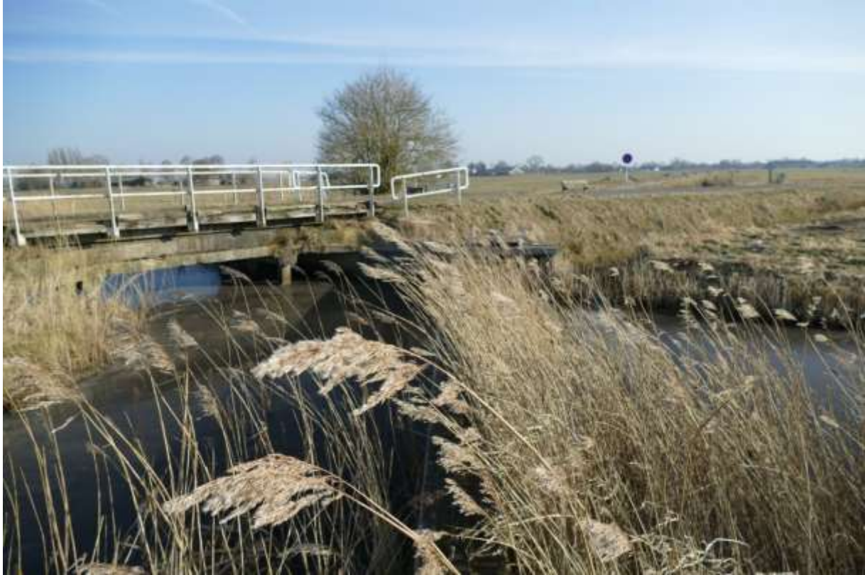
Brug Westersanning en stuw.
